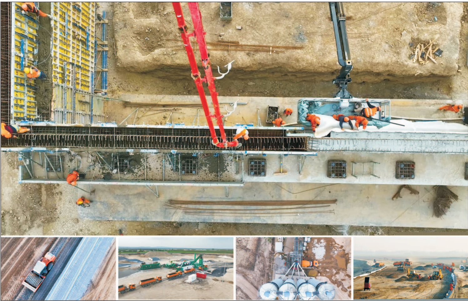
Conform datelor CNAIR, în cazul lotului 2 al sectorului Buzău-Focșani, UMB a dislocat un număr impresionant de resurse umane și echipamente. Lotul 2 este în faza finală a lucrărilor, cu trasarea marcajelor rutiere deja începută, ceea ce indică un progres avansat. (Sursa foto: facebook / UMB)
